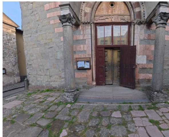
20 Seconda rampa per accedere all'ingresso della Chiesa
